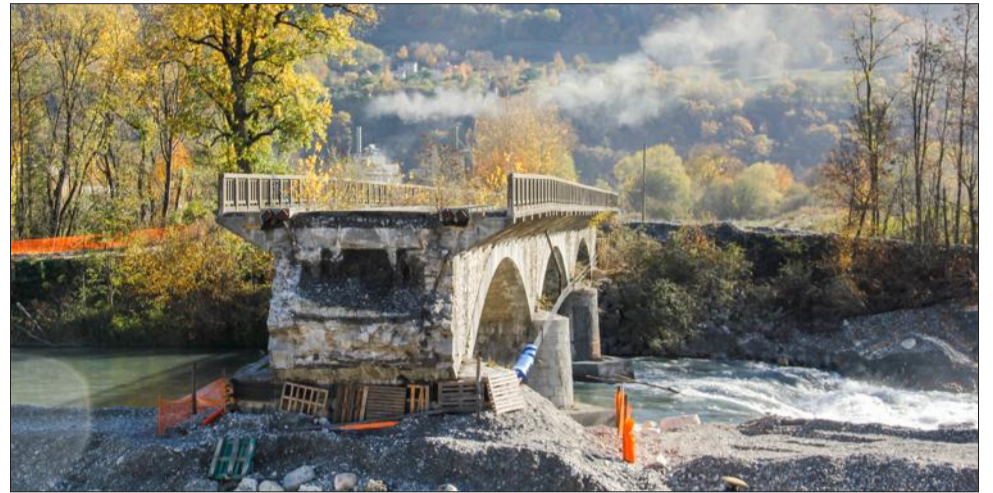
La partie du pont encore en place se situe sur la rive gauche côté Cheylas. Sa démolition va intervenir en janvier prochain. La digue spécialement aménagée pour accueillir les matériaux de la partie du pont démolie (photo ci-dessous) va être carrément déplacée de l'autre côté du chantier. Et il est impératif de le faire d'ici la fin de l'année, car le niveau de l'Isère sera encore bas. Photos Le DL/Chloé PONSET et Cabinet Ritz architecte atelier
