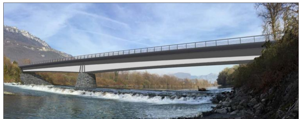
Voici le profil du nouveau pont de La Buissière qui franchit l'Isère et permet de relier La Buissière au Cheylas et inversement. Il aura une longueur de 120 mètres (comme l'ancien) avec un tablier en béton armé d'une largeur de 8,10 mètres reposant sur des poutres en acier de hauteur variable.
